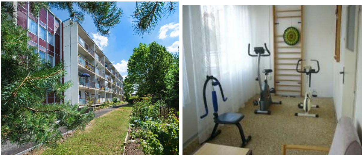
Obrázek č. 18 Objekt Albrechtická 1074, Most
