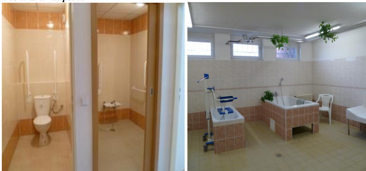
Obrázek č. 6 Objekt Jiřího Wolkerova 404, Most – zrekonstruovaná sociální zařízení a centrální koupelna
