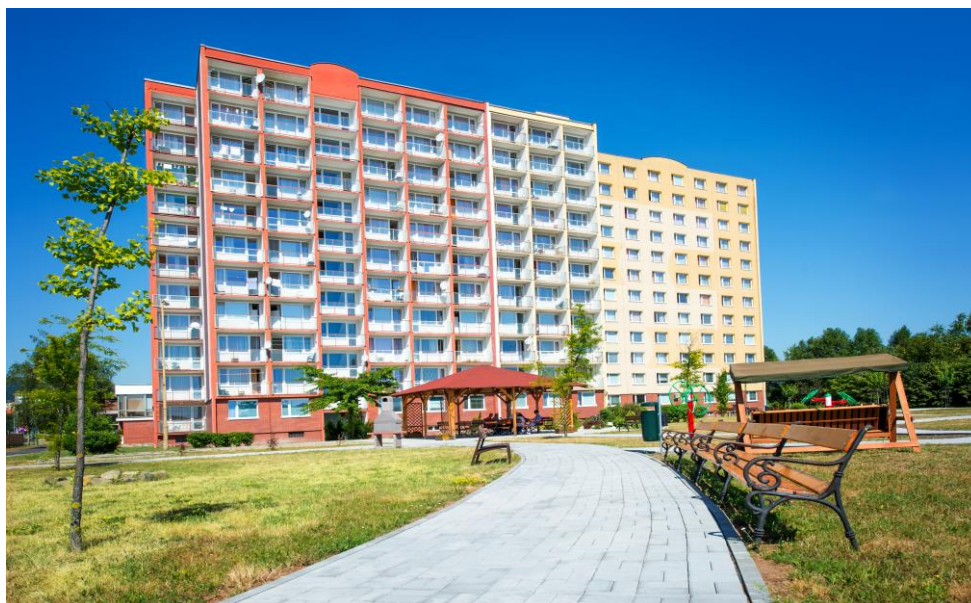
Obrázek č. 2 Objekt Barviřská 495, Most
