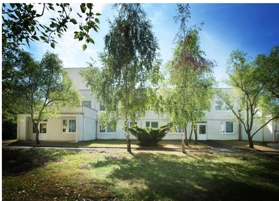
Obrázek č. 12 Objekt Františka Malíka 973, Most
