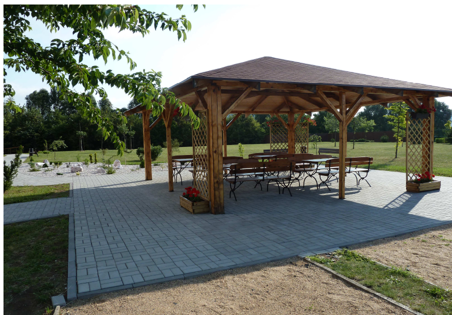
Obrázek č. 4 Objekt Barvířská 495, Most – altán na zahradě
