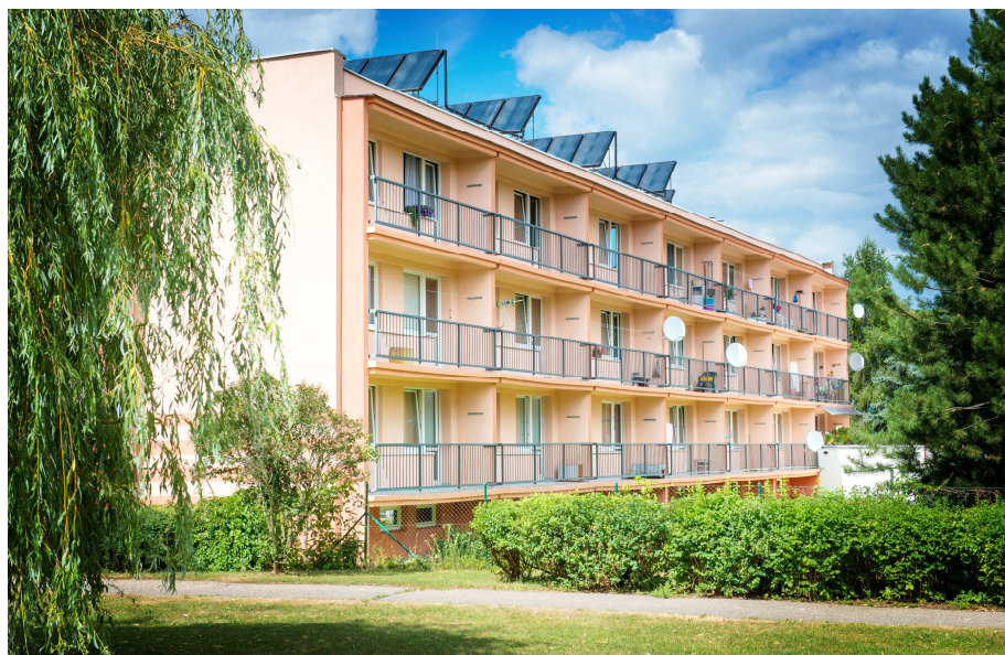
Obrázek č. 5 Objekt Jiřího Wolкера 404, Most
