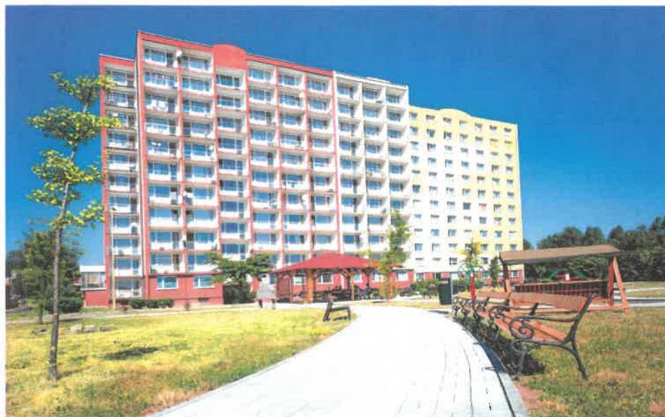
Obrázek č. 2 Objekt Barvířská 495, Most
