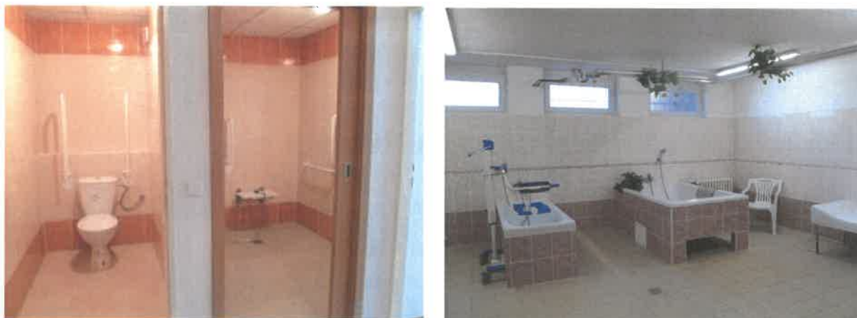
Obrázek č. 6 Objekt Jiřího Wolkerova 404, Most – zrekonstruovaná sociální zařízení a centrální koupelna
