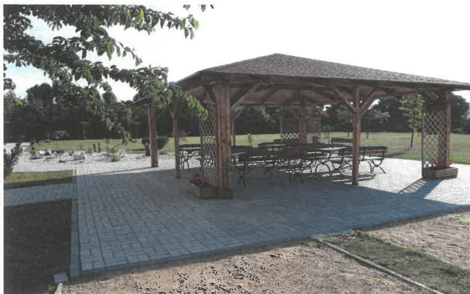
Obrázek č. 4 Objekt Barvířská 495, Most – altán na zahradě
