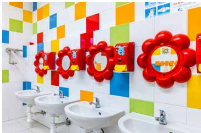
Denní dětský rehabilitační stacionář – sociální zařízení
